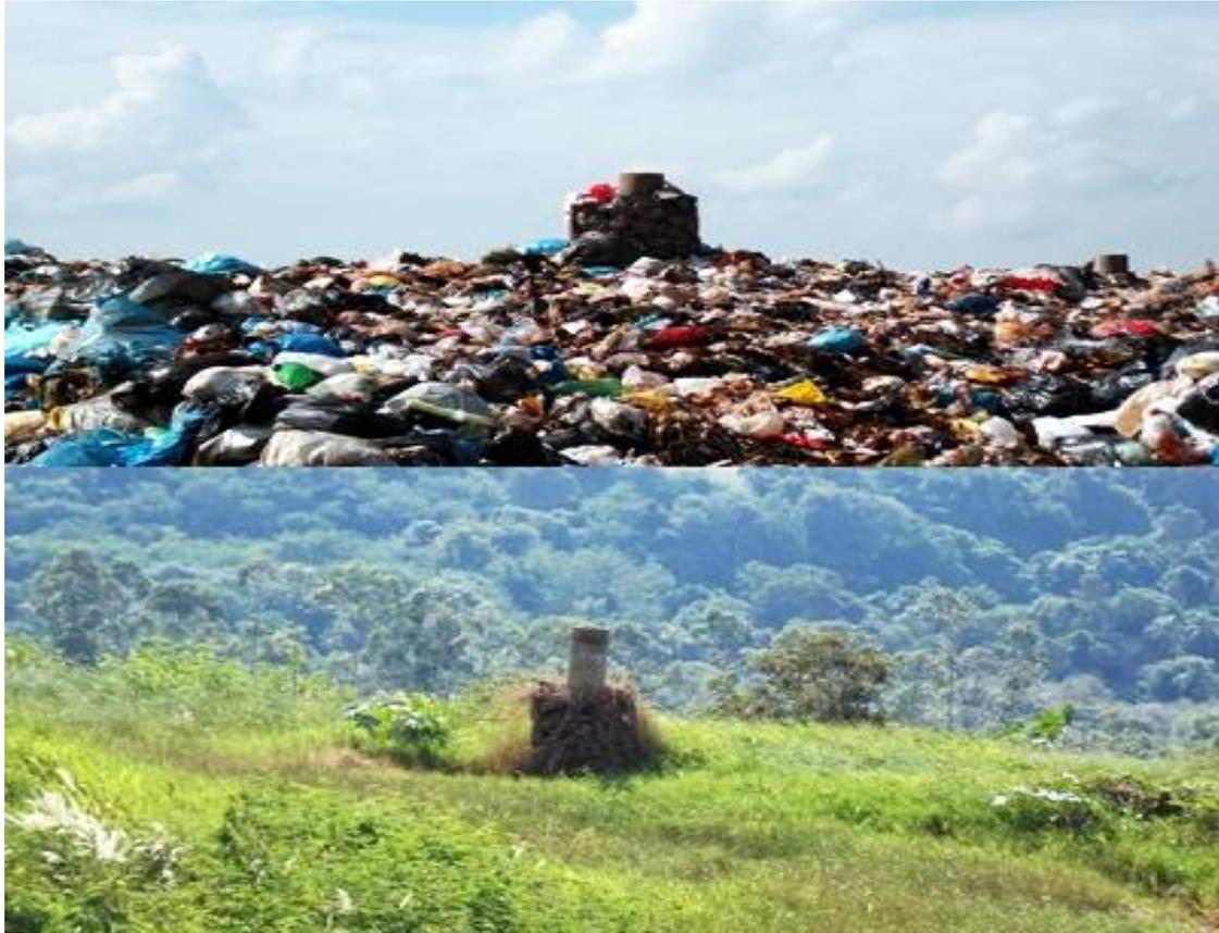
Figura 5: Chaminés para liberação de gás de uma célula ativada e uma desativada.
