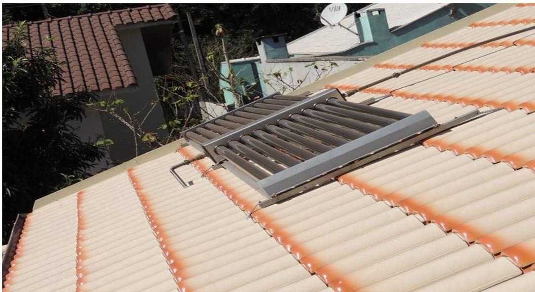
Figura 2: Coletores solares de tubos a vácuo de uma residência particular.
