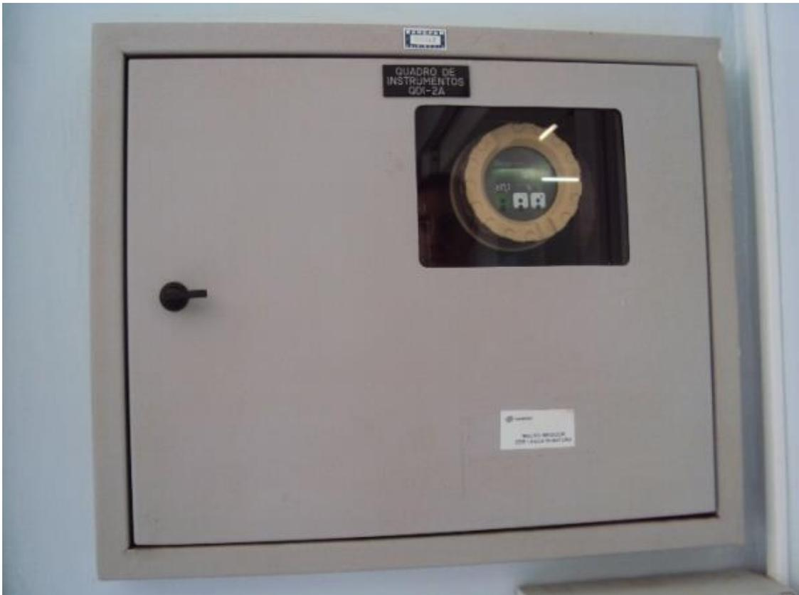
Figura 12: Macromedidor de água *innatura*.
