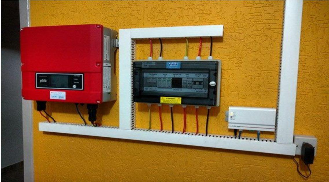
Figura 2: Inversor para transformar corrente contínua em corrente alternada.
