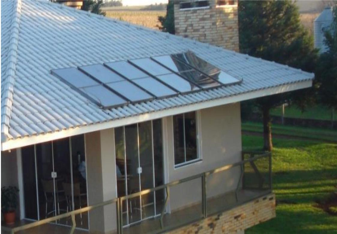
Figura 1: Placas coletoras solares de vidro de uma residência particular.
