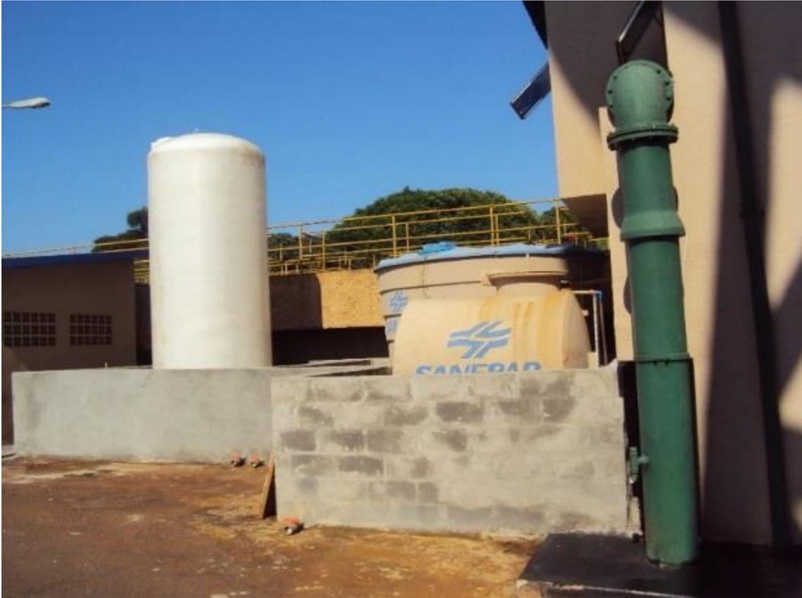
Figura 7: Tanque de contenção com o Reservatório de Sulfato de Alumínio e Reservatório da cal hidratada.
