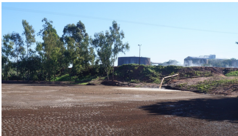
Figura 1 - Lagoa de distribuição da vinhaça da usina. Fonte: Arquivo pessoal
