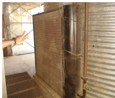
Fonte: Foto do autor (2013) Figura 23 – Trocador de Calor
