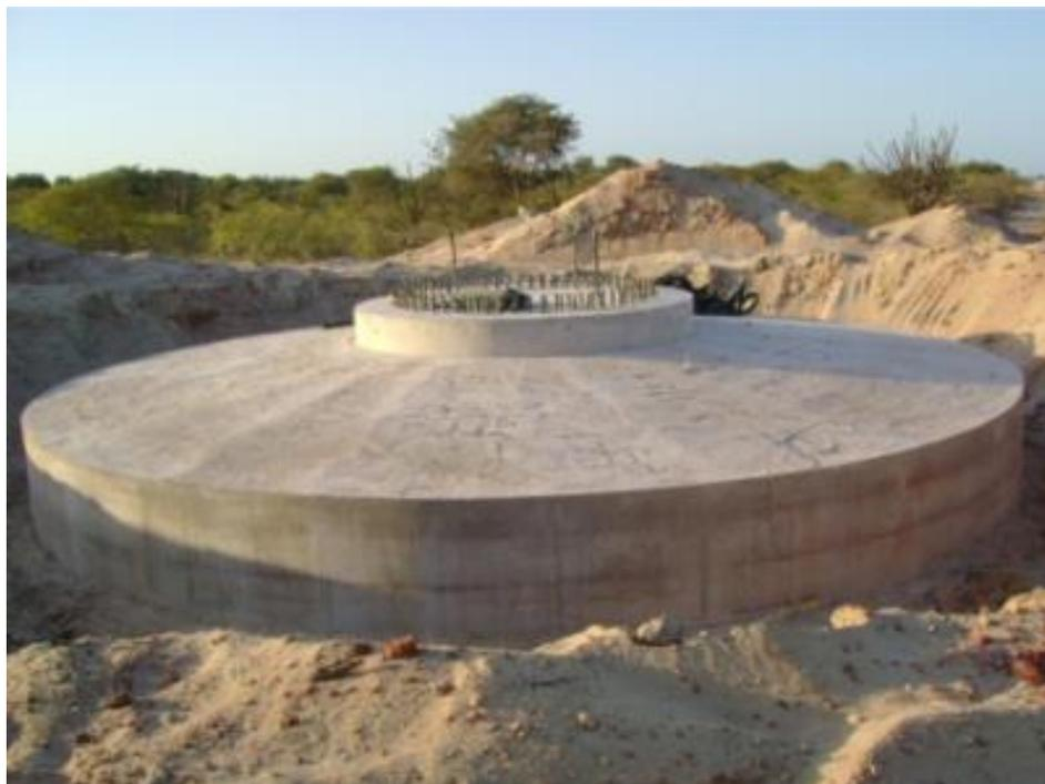
**Figura 15** – Bloco de fundação para aerogerador
