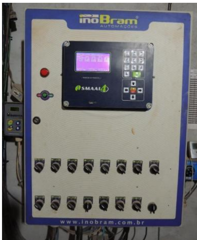
Figura 22: Sistema de controle do aviário A1 – Inobram SMAAI 4.
