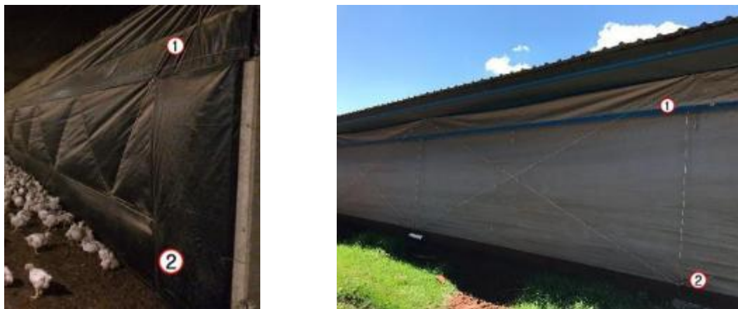
Figura 18: Vedação lateral do aviário A2. Detalhe do fechamento lateral. (1) Bandô tipo Y com beiral na cor preto - prata (face interna - face externa) (2) Cortina preta – prata (face interna – face externa).
