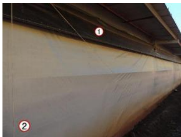
Figura 17: Vedação lateral do aviário A1. Detalhe do fechamento lateral. (1) Bandô tipo Y na cor preta (2) Cortina preta – prata (face interna – face externa).
