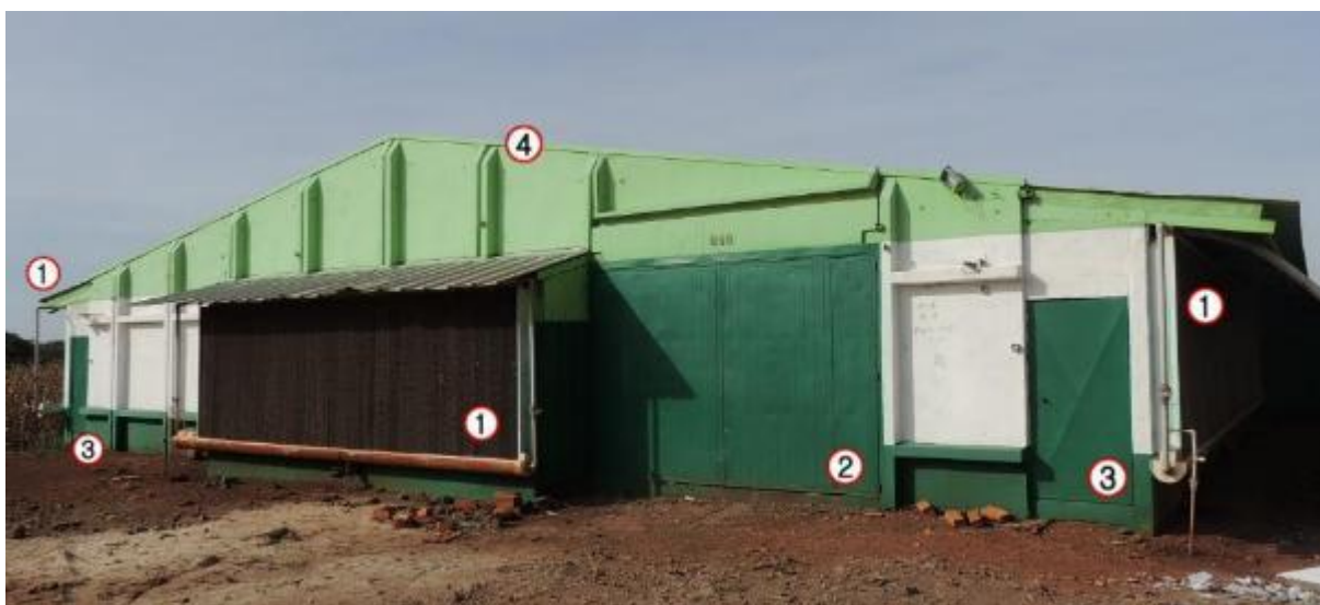
Figura 15: Elevação oeste – leste do aviário A1. Detalhe da fachada frontal. (1) Pad cooling . (2) Porta de manutenção do alojamento ao abate (3) Porta de acesso ao Pad cooling (4) Estrutura pré-moldada de concreto.
