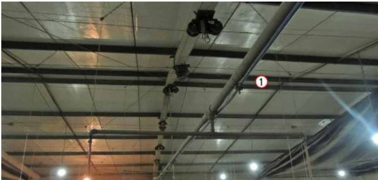
Figura 25: Sistema de resfriamento – Nebulizador. (1) Mangueira e biqueiras responsáveis pelo processo de nebulização.
