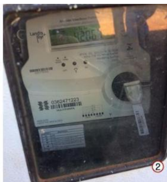
Figura 61: (1) Aviário A1. Medidor eletrônico de energia Landis Gyr modelo Saga 1500 (2) Aviário A2. Medidor eletrônico polifásico Landis Gyr modelo E34A.
