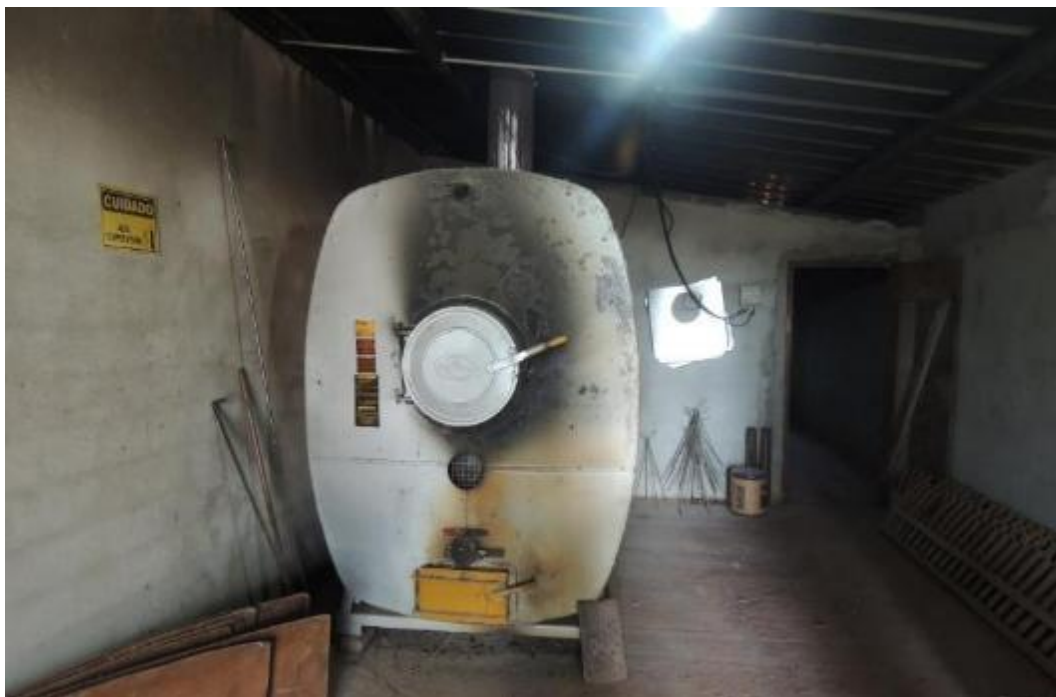
Figura 23: Sistema de aquecimento do aviário A1 – Forno a lenha.
