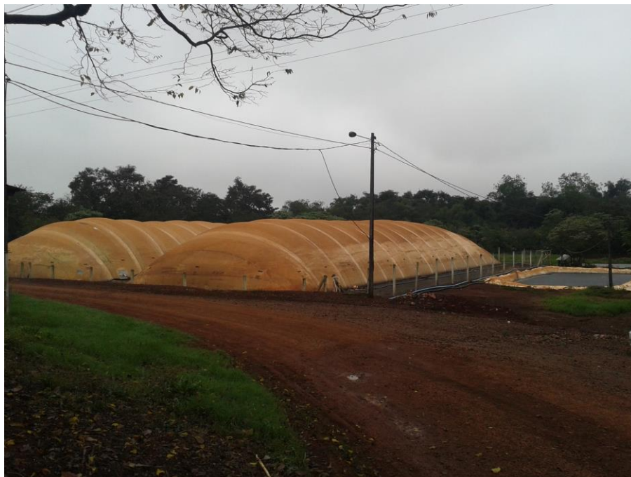
Figura 5. Biodigestores da Granja Jucélia – São Miguel do Iguaçu-PR.
