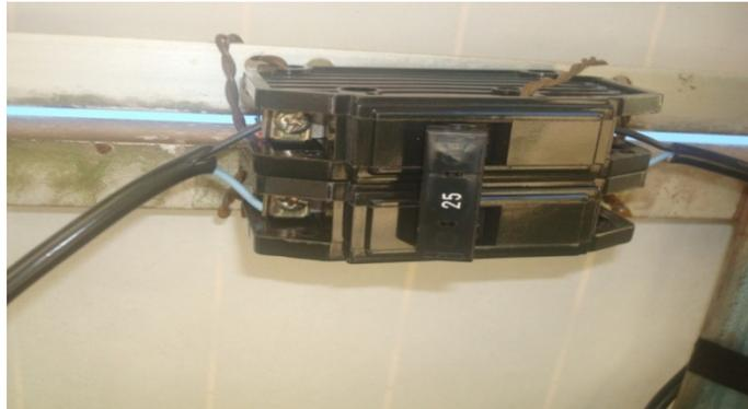
Figura 14 – Disjuntor bipolar de 25A.
