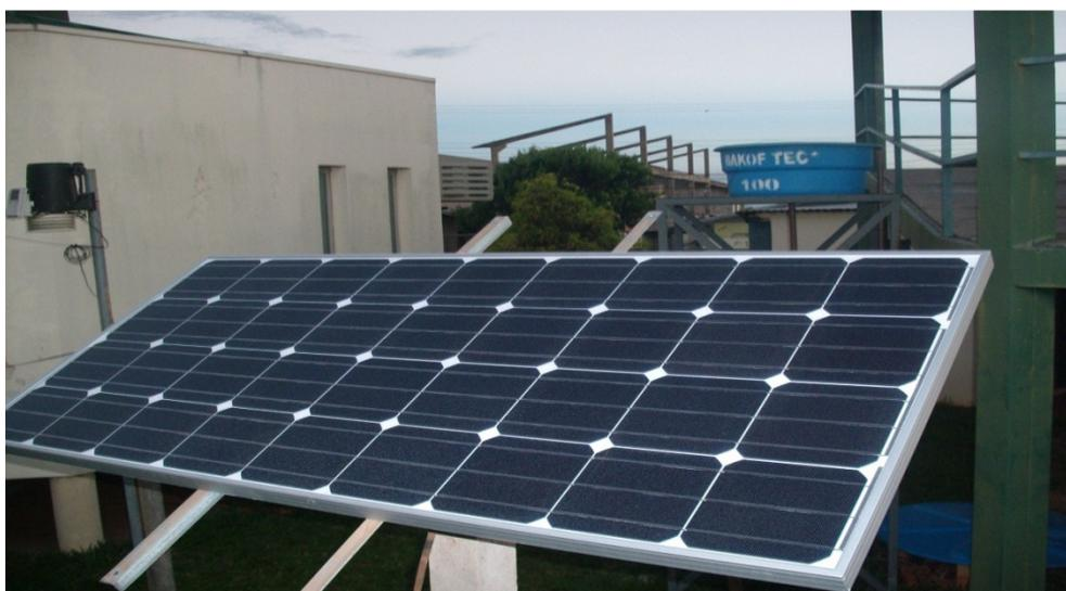
Figura 11– visão geral do módulo fotovoltaico monocristalino instalado.
