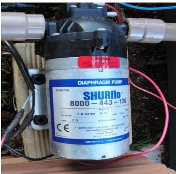
Figura 12 – Motobomba de superfície Shurflo 8000
