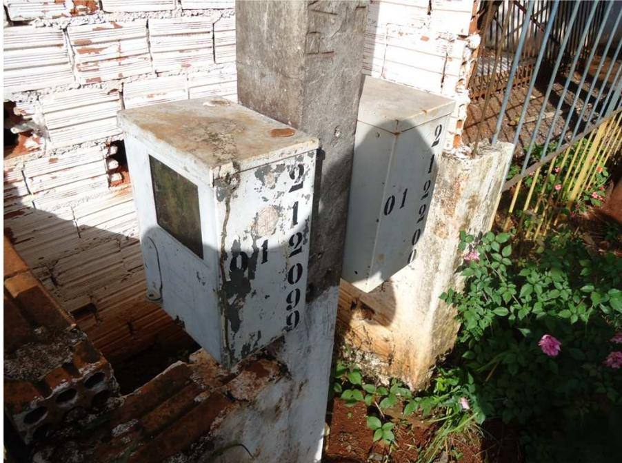
Figura 12: Verificação *in loco* dos padrões de entrada para identificar quantas Unidades Consumidoras há no lote.
