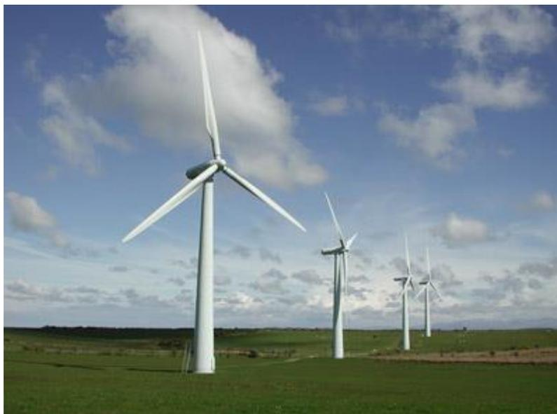
Figura 3: Aerogerador de eixo horizontal.
