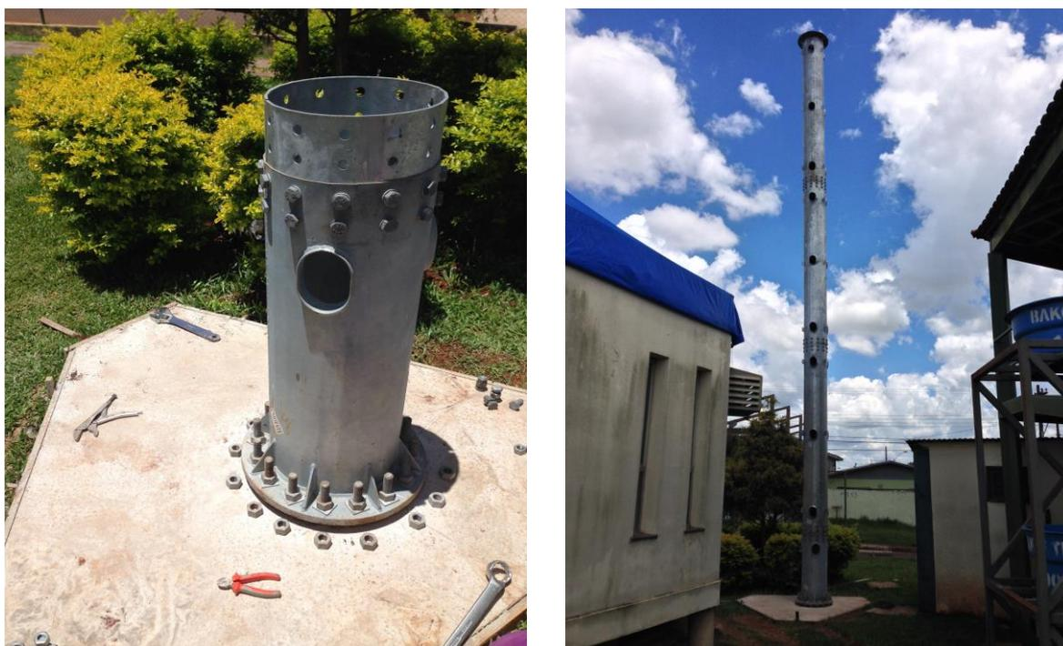
Figura 11: Torre e base de fixação.
