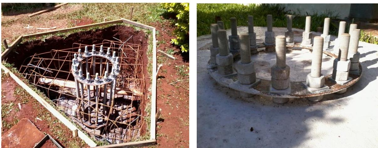
Figura 10: Fundação e estrutura interna.
