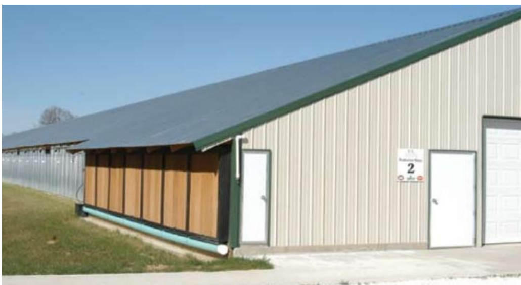
Figura 18: Detalhe sistema pad coolings, em um aviário dark house . (Fonte: COBB-VANTRESS, 2008)
