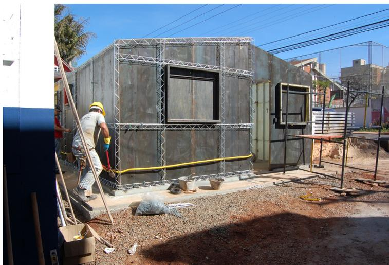
FIGURA 15 - Montagem das paredes internas com as treliças
