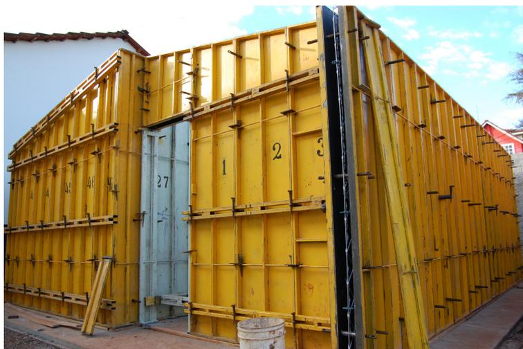
FIGURA 16 - Montagem das paredes externas.
