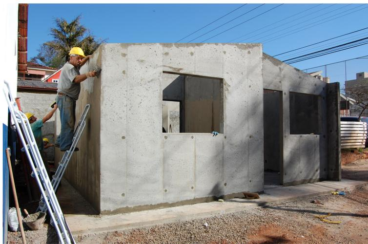
FIGURA 718 - Parede pronta para receber acabamento.
