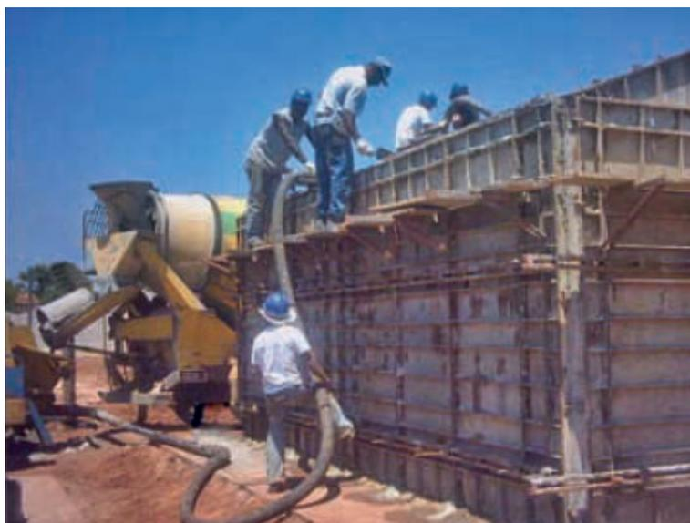
FIGURA 17- Concretagem da parede.
