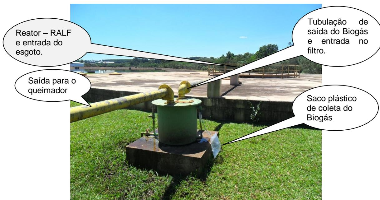
Figura 8. Vista do RALF N.º 2 montado com o coletador de biogás.
