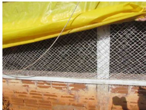
Figura 4 – Fechamento lateral do aviário convencional. Fonte: Foto tirada pelo autor, 2013.
