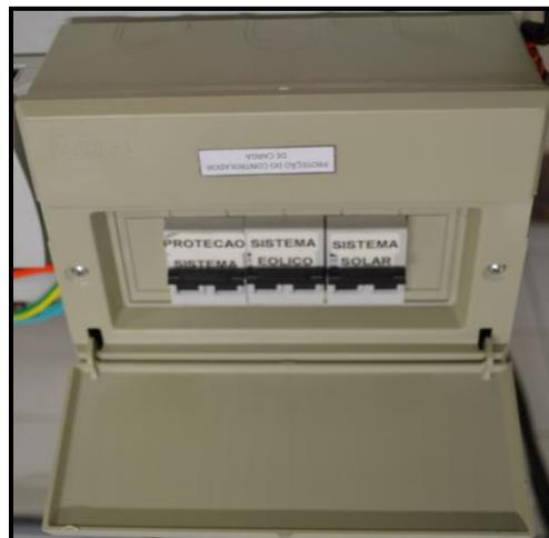
**Figura 26** – Proteção do controlador de carga – três disjuntores SOPRANO de 16 A.
