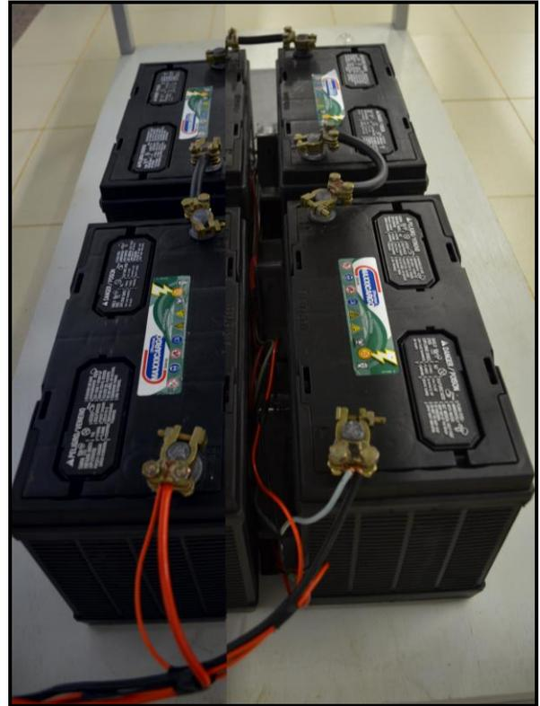
**Figura 30** – Banco de baterias de chumbo-ácido 100 Ah, associadas em série, com quatro unidades.
