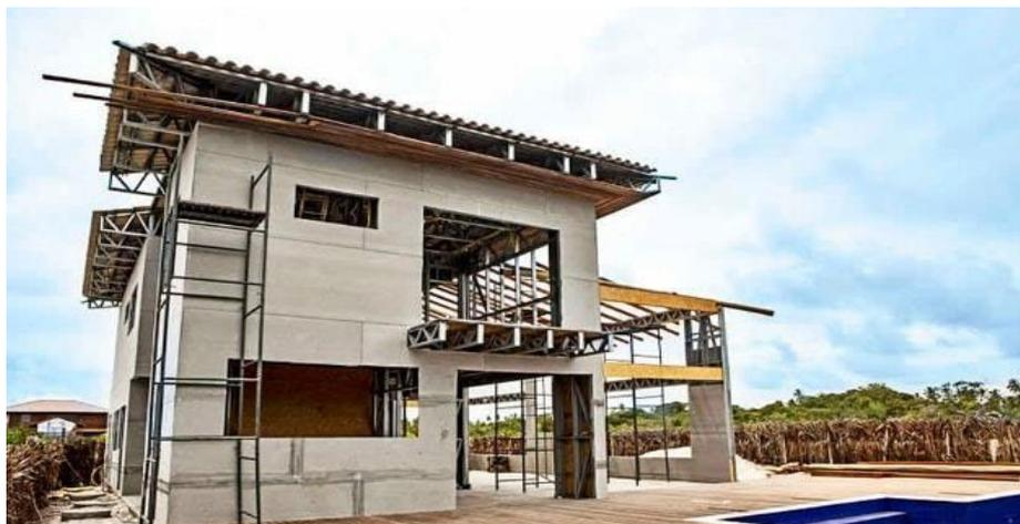
**Figura 4.** Construção em *steel Frame*.
