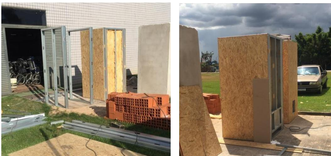
**Figuras 20 e 21.** Execução dos protótipos de *steel frame*.
