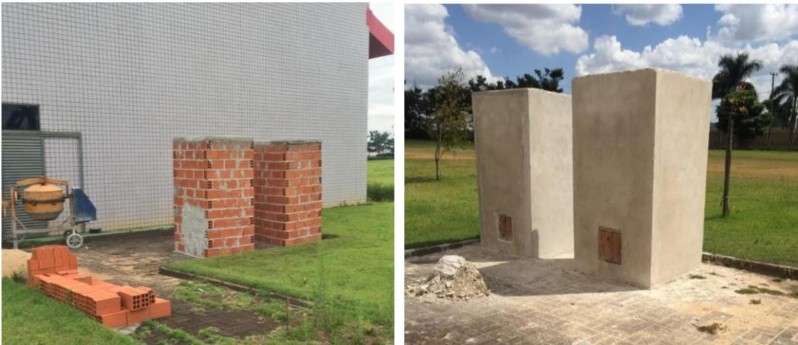
**Figuras 18 e 19.** Execução dos protótipos de bloco cerâmico.
