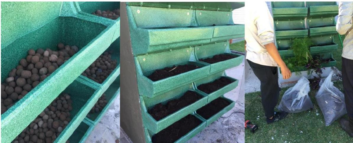
**Figuras 28, 29 e 30.** Execução do Jardim vertical – colocação de argila expandida, terra e planta.
