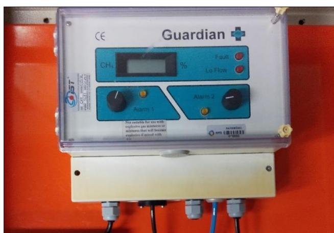
**Figura 11.** Transmissor de concentração de metano
