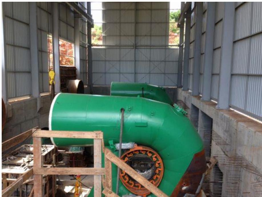
Figura 10 - Turbina do Tipo Francis de eixo horizontal instalado na PCH Moinho
