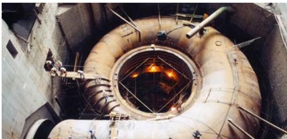
Figura 12 - Turbina Francis Eixo Vertical
