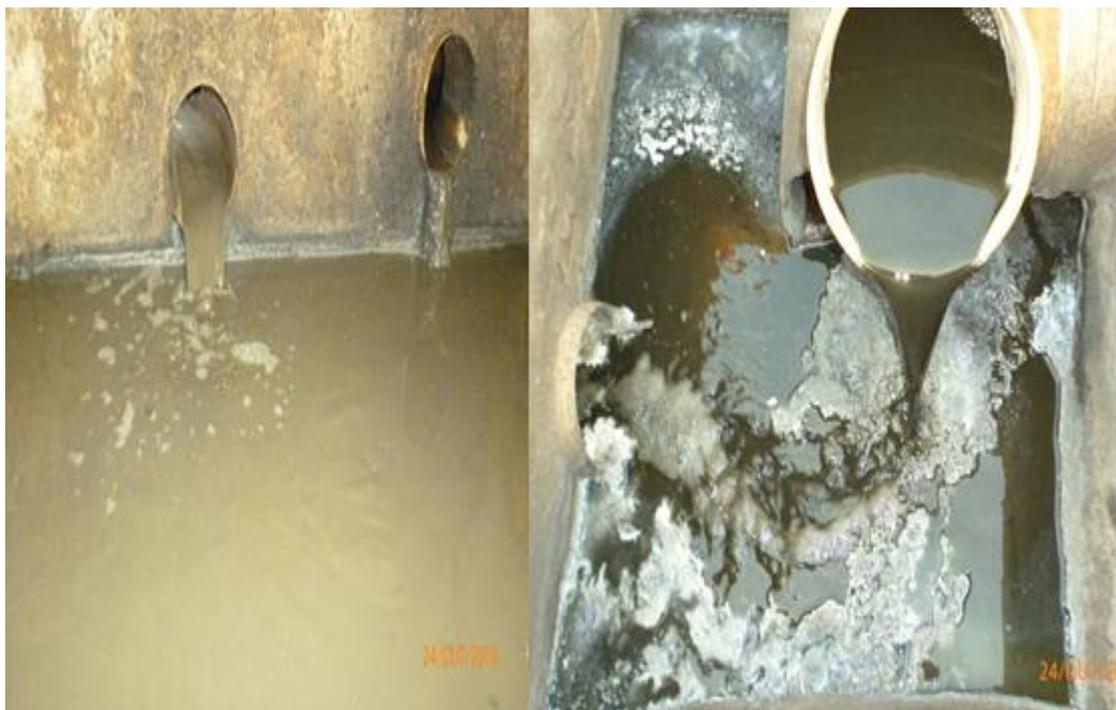
**Figura 15:** Entrada e Saída do biodigestor modelo A.
