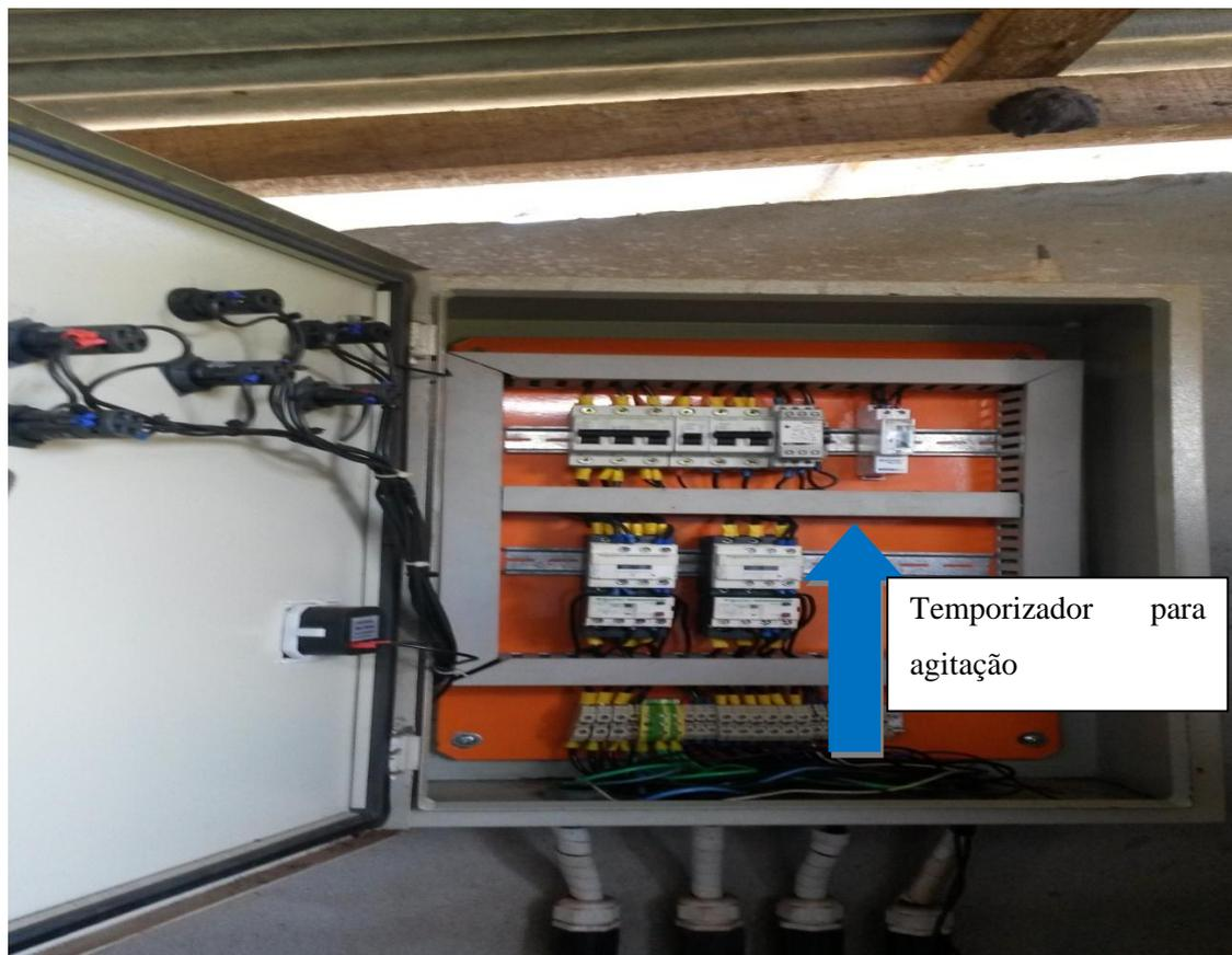
**Figura 8:** Painel de controle instalado na casa de maquinas do biodigestor
