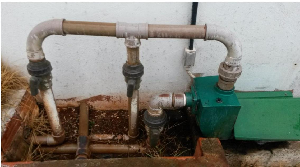
**Figura 7:** Arranjos típicos de registros para controle da agitação.
