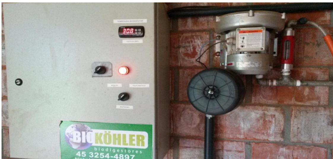
**Figura 13:** Foto do painel de controle e compressor para injeção de ar.
