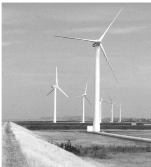
Figura 2: Usina eólica (BURTON et al., 2001)
