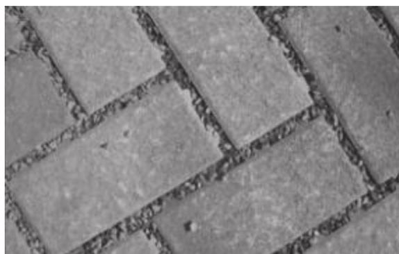
Figura 4. Pavimento com revestimento constituído por peças de concreto com juntas alargadas.
