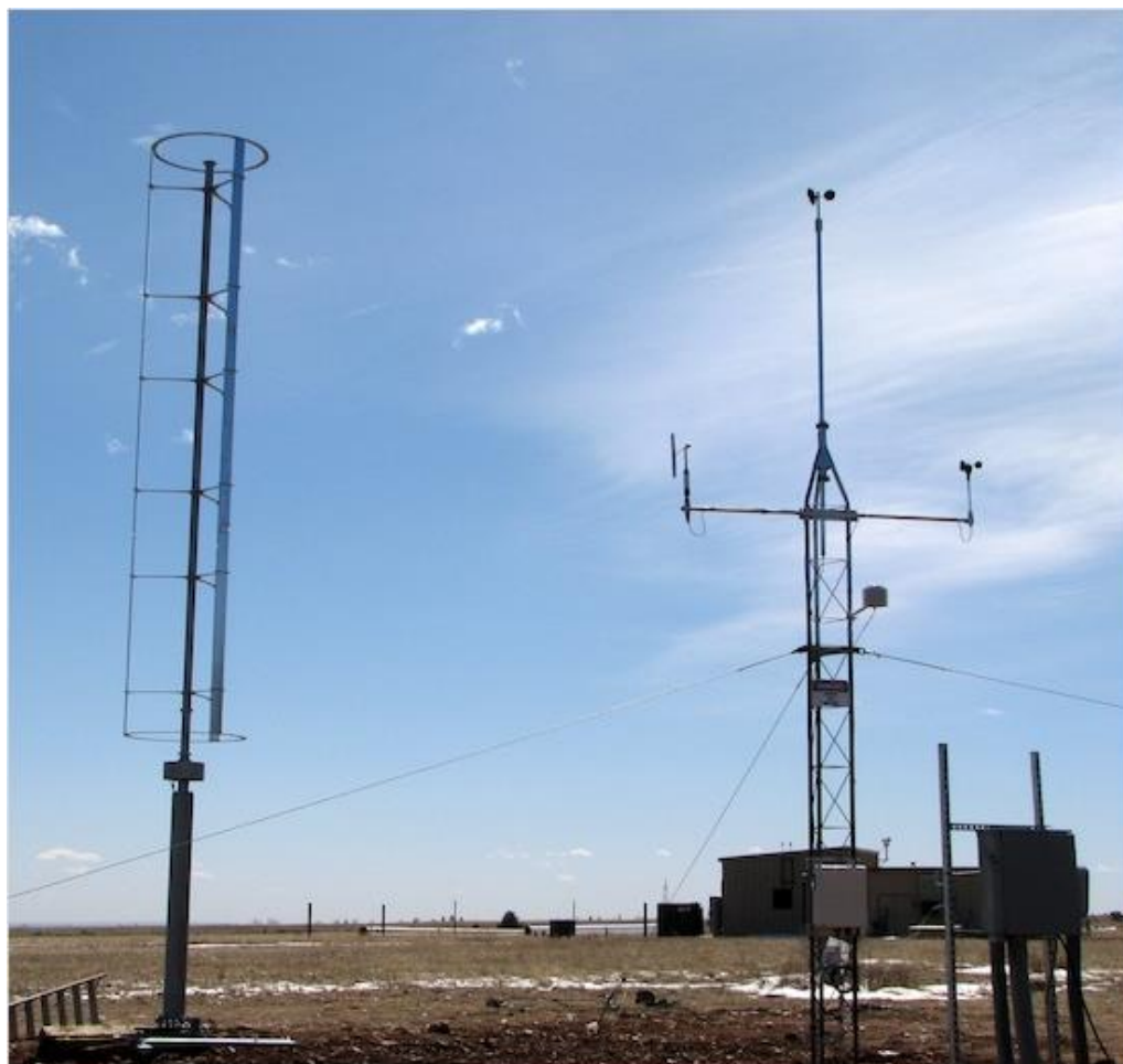
Figura 2: Aerogerador de eixo vertical
