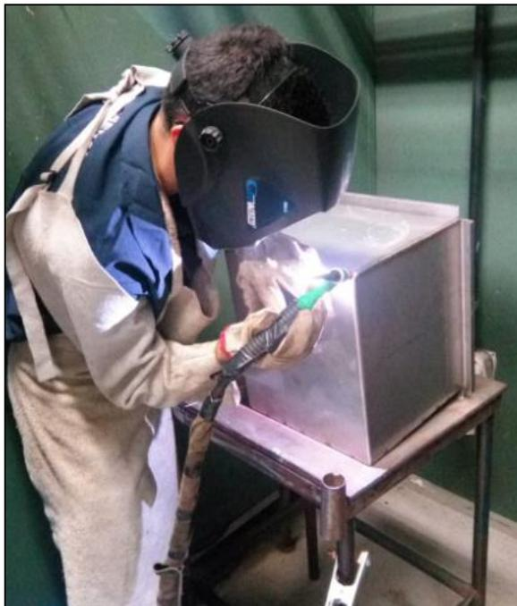
**Figura 21.** Processo de soldagem TIG no reservatório.
