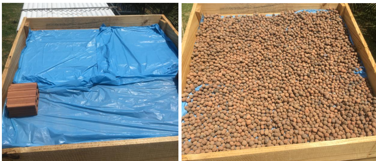
Figuras 18 e 19 – Camadas da montagem do protótipo do telhado verde, manta impermeabilizante e argila expandida Fonte: Autora (2020)
