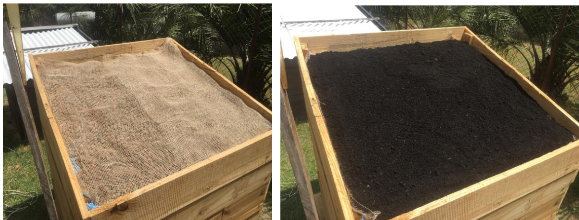
Figuras 20 e 21 – Camadas da montagem do protótipo do telhado verde, tecido geotêxtil e substrato arenoso Fonte: Autora (2020)
