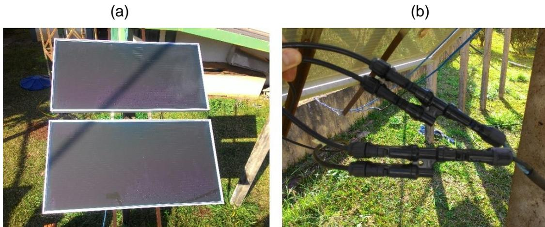
Figura 19. Painel Fotovoltaico amorfo instalado (a); conector tipo Y, ligado em paralelo (b).
