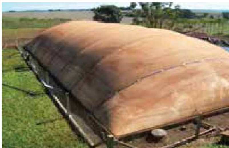
Figura 4: Exemplo de biodigestor tubular em propriedade rural (Barichello et al. , 2015).
