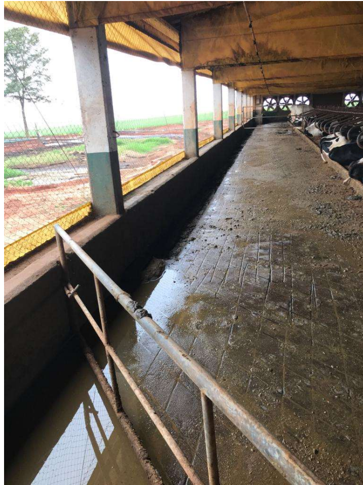
Figura 8: Detalhe de uma das canaletas do barracão (AUTORA, 2018).
