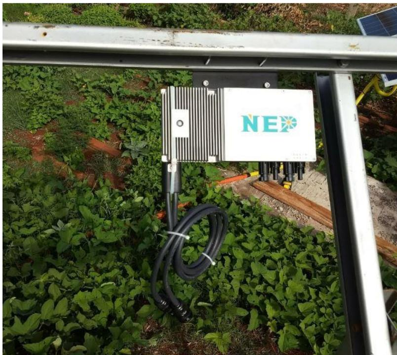
Figura 31 – Fixação do Microinversor na Estrutura.
