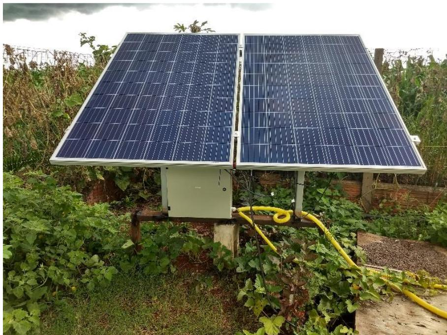
Figura 34 – Instalação do Quadro Elétrico na Estrutura Fixa.
