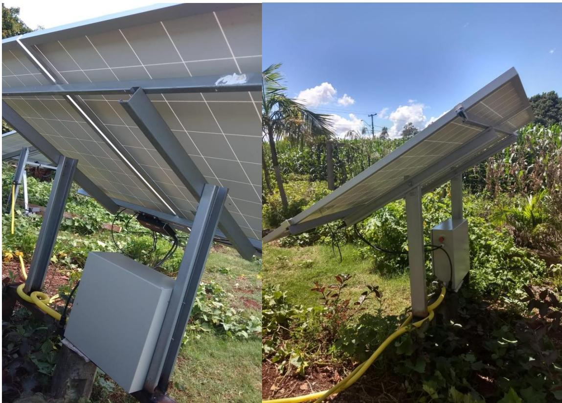
Figura 33 - Fixação dos Painéis Fotovoltaicos na Estrutura Fixa.
