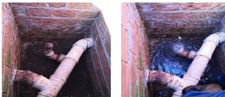
Figura 6 - Sistema de remoção de água do biogás
