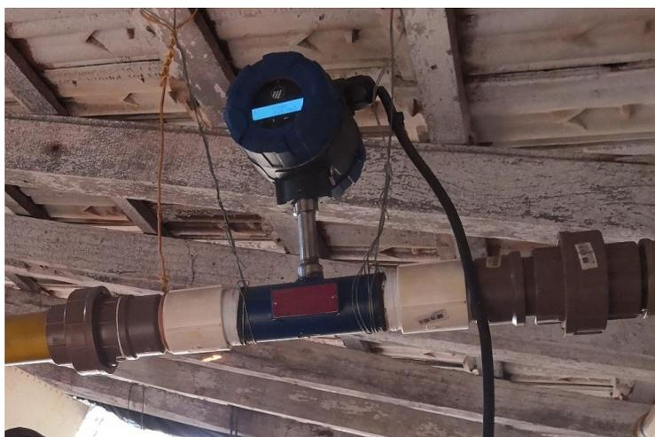
Figura 10 - Medidor de vazão do biogás
