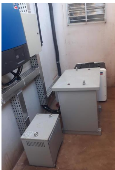
Figura 34 - Instalação dos inversores e autotransformadores no local..
