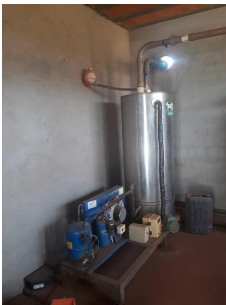
Figura 29 - Filtro para retirada de umidade do biogás.
