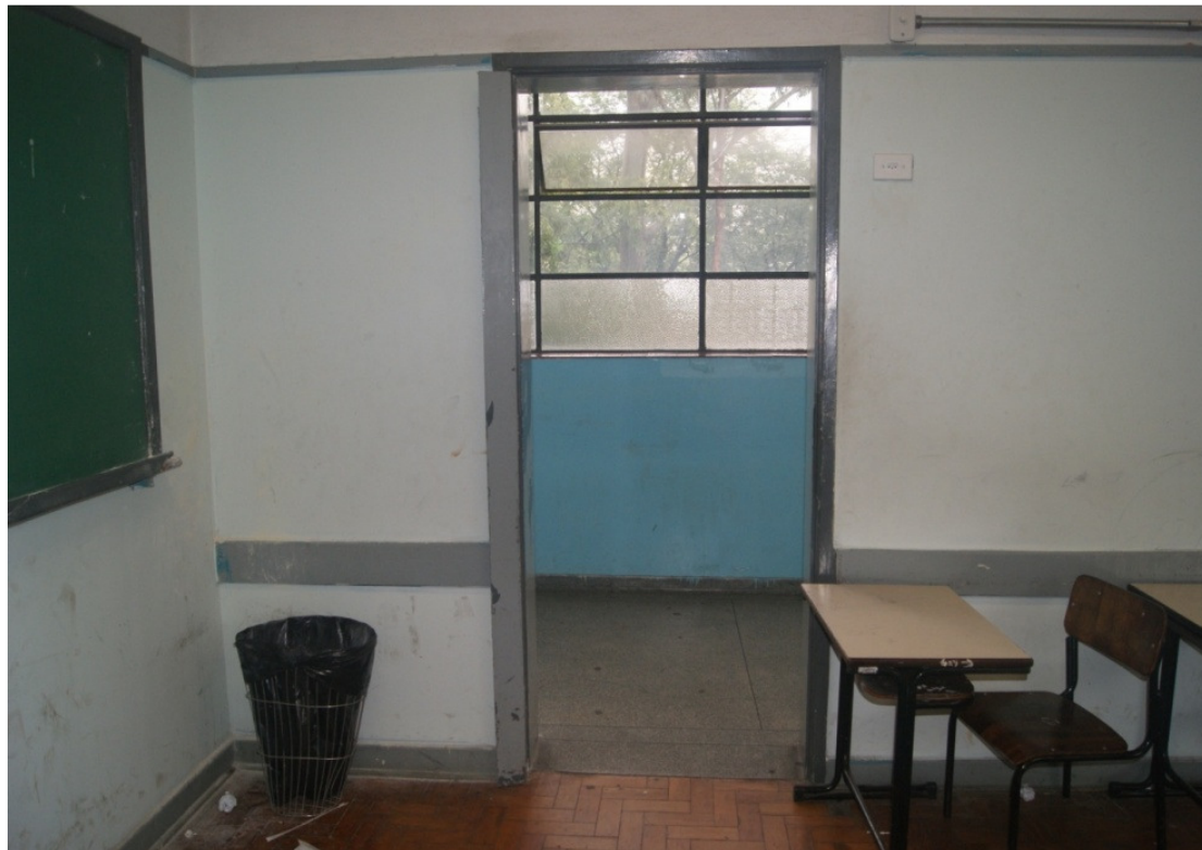
Figura 28 - Sala sem porta e suja durante vigência das salas fixas. Foto do autor. 2014.
