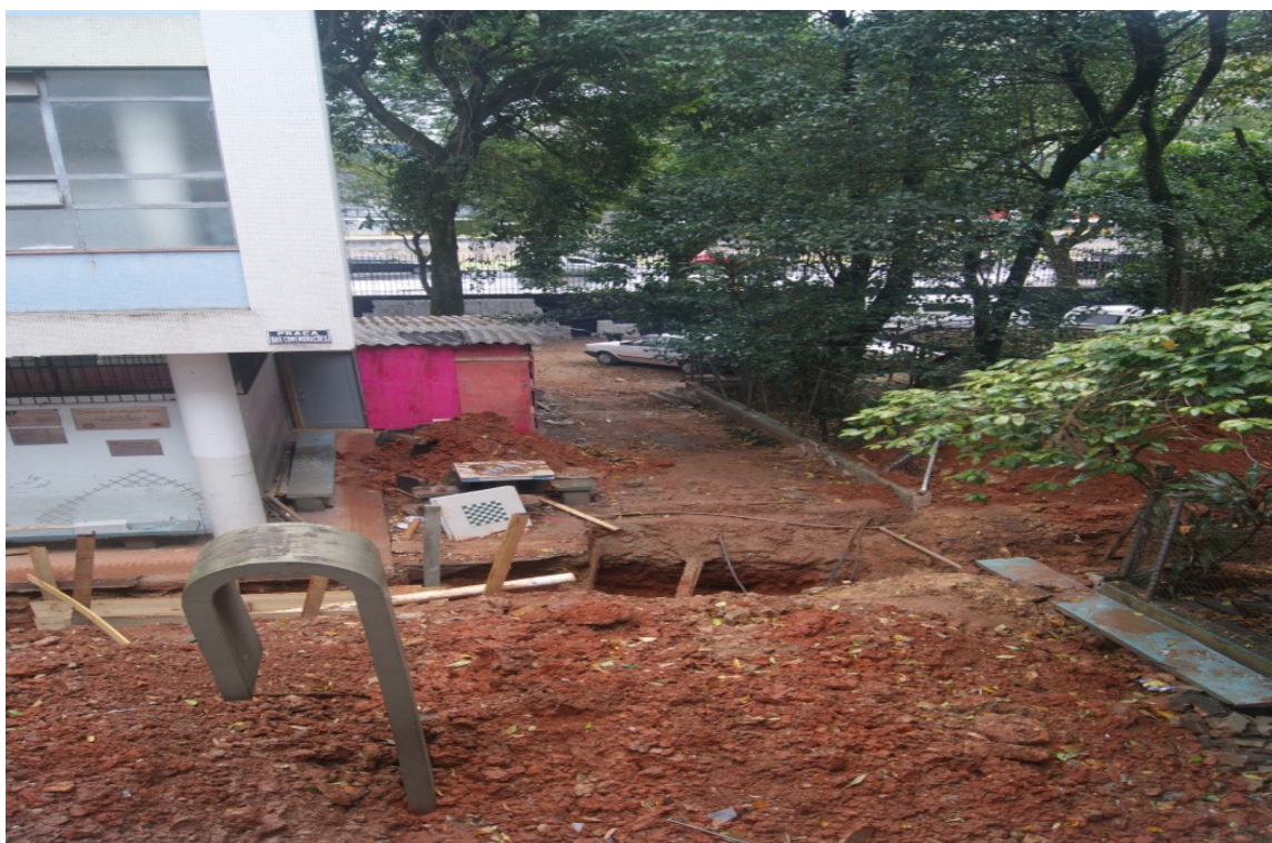
Figura 27- Escola Alfa em reforma. 2012. Foto do autor.
